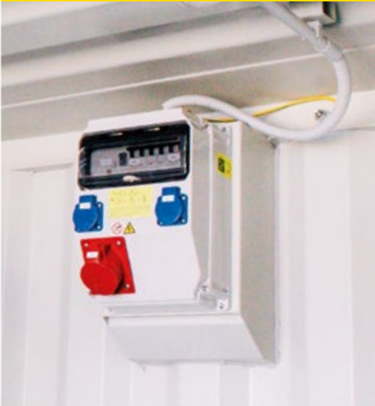
Verteilerkasten mit integrierten Steckdosen
